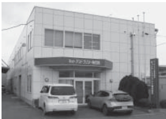
来春に新社屋建設が完成予定 (写真は現在の仮工場)
