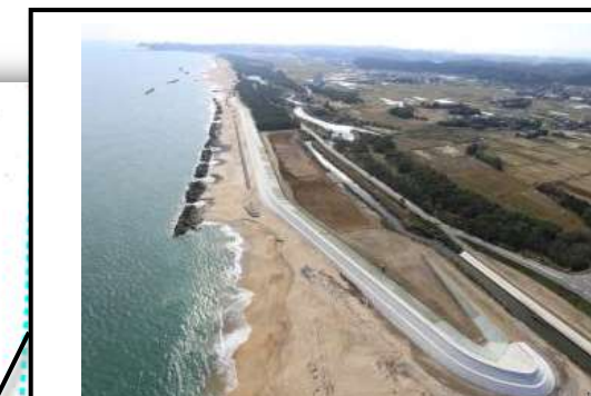
夏井海岸の海岸堤防（福島県いわき市） （復興庁 HP より）
