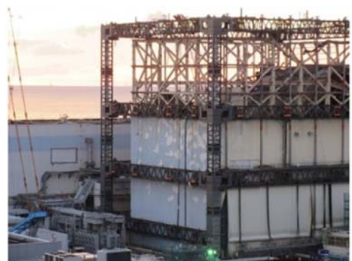
(1号機建屋カバー壁パネル取外状況)
