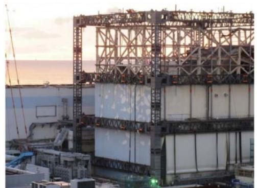
(1号機建屋カバー壁パネル取外状況)
