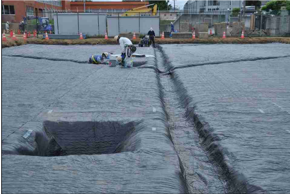
汚染表土は6面を遮水シートで覆う (2011/May/27)
