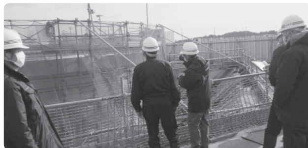
▲ 建設中の双葉水処理センターを見学
