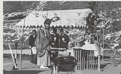
石熊砂防ダムの起工式=昭和51年2月
