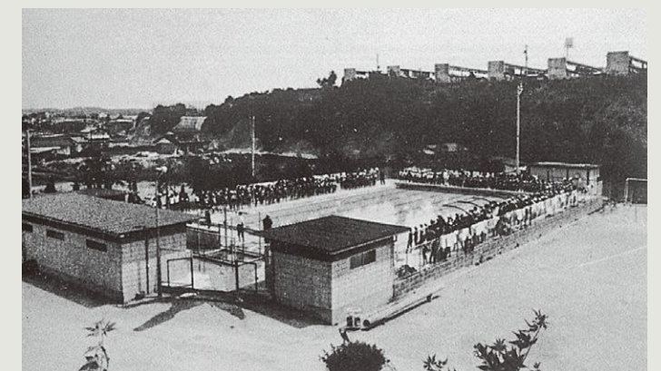
双葉南小に完成したプール=昭和48年7月
