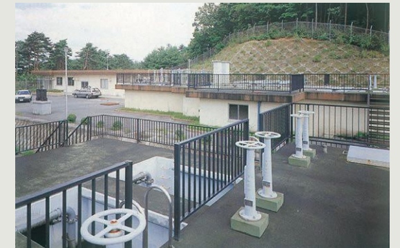
完成した石熊浄水場=昭和60年3月
