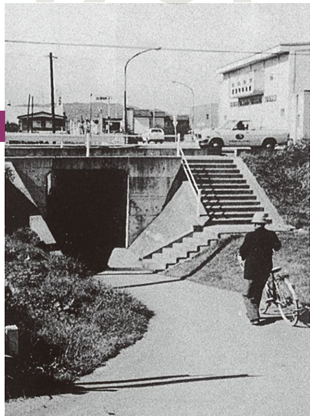
完成した久保前の地下道 昭和47年3月
