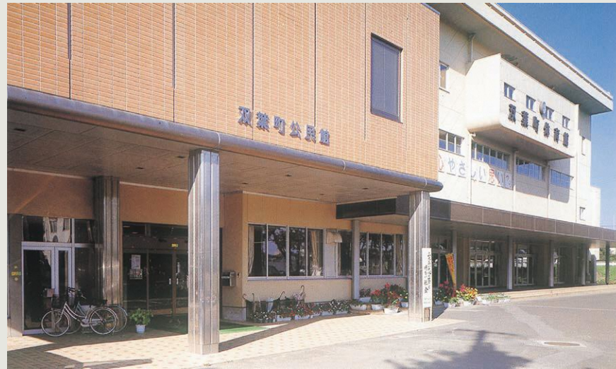
隣接する町体育館と町公民館
