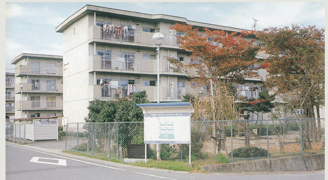
町営住宅の前田団地
