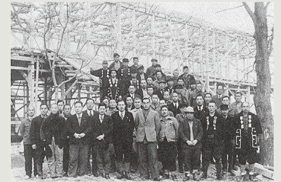
標葉中学校の校舎建築の上棟式=昭和27年8月
