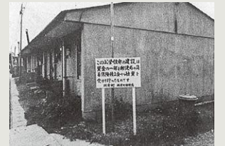
完成した町営住宅の下条団地=昭和44年3月
