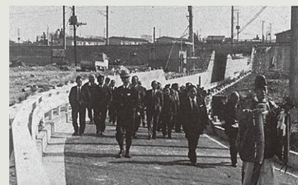
目迫線地下道の開通式=昭和51年3月
