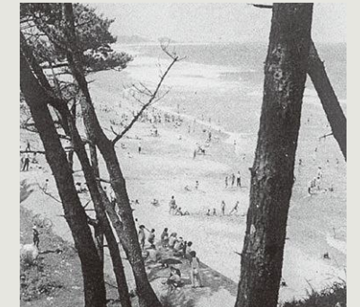
護岸工事が行われた郡山海岸=昭和31年3月
