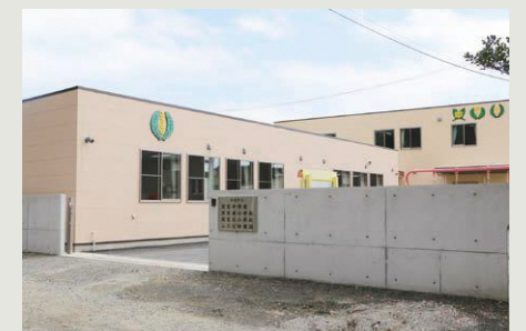
双葉町のふたば幼稚園、双葉南、双葉北両小学校、双葉中学校の仮設校舎
