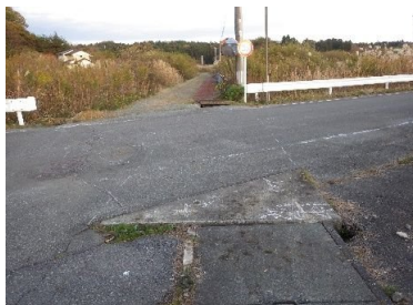
損傷状況（床版鉄筋露出）
