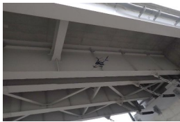
ドローンによる桁下の点検
