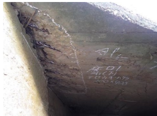
損傷状況（床版鉄筋露出）
