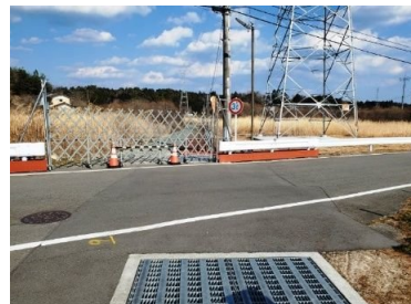
中：新橋全景（左側）
