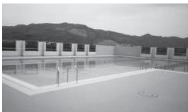
② 屋上プール
