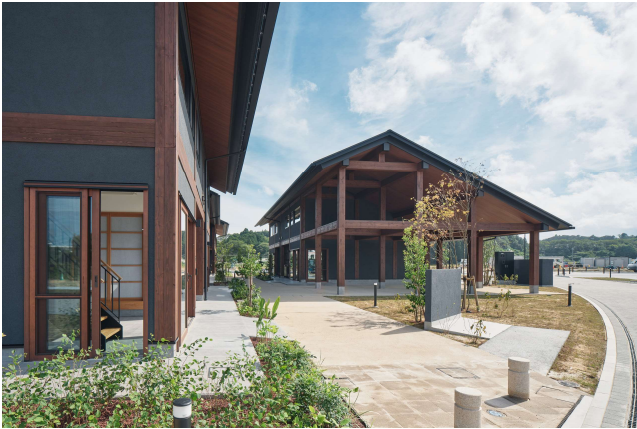
駅西住宅外観
