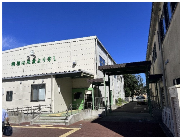
写真：仮設校舎（いわき市錦町）
