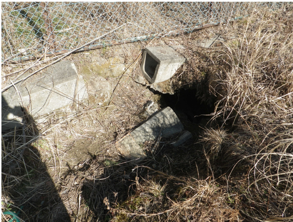
写真 3：双葉中学校グラウンドの北側亀裂と排水溝破損状況(拡大)。2021. 2. 19
