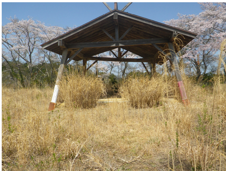
写真 1：アルミケーシングパイプ撤去後状況。2011. 3. 31
