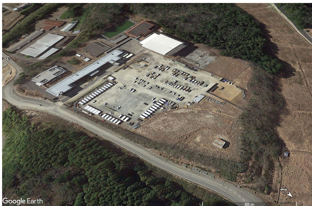
写真 7：現在の双葉中学校グランドの亀裂状況に大きな変化は確認されない。2020. 3. 19
