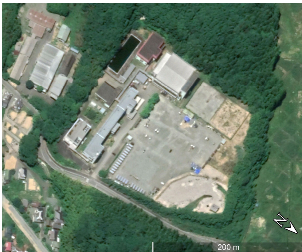
写真 6：7 年後の双葉中学校グランドの亀裂状況に大きな変化は確認されない。2018. 7. 2
