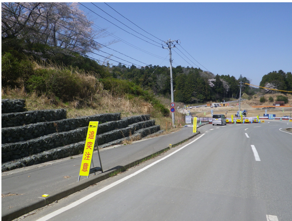
写真 11：法面工事後の現在の双葉中学校グランドの斜面状況。2021. 3. 31
