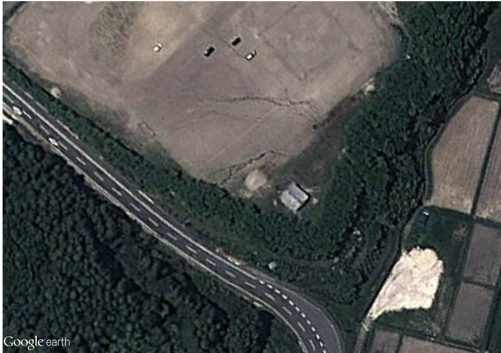
写真 4：震災後の双葉中学校グランドの亀裂状況が確認される。2011. 5. 18
