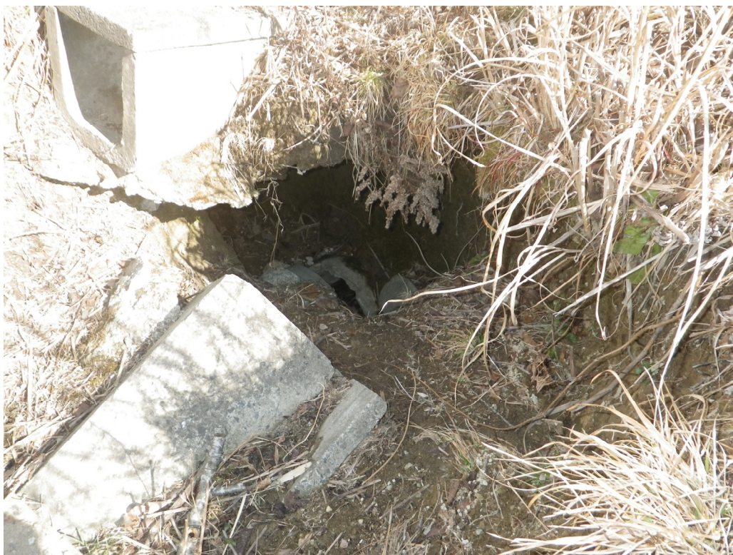
写真 3：双葉中学校グラウンドの北側亀裂と排水溝破損状況(拡大)。2021. 2. 19
