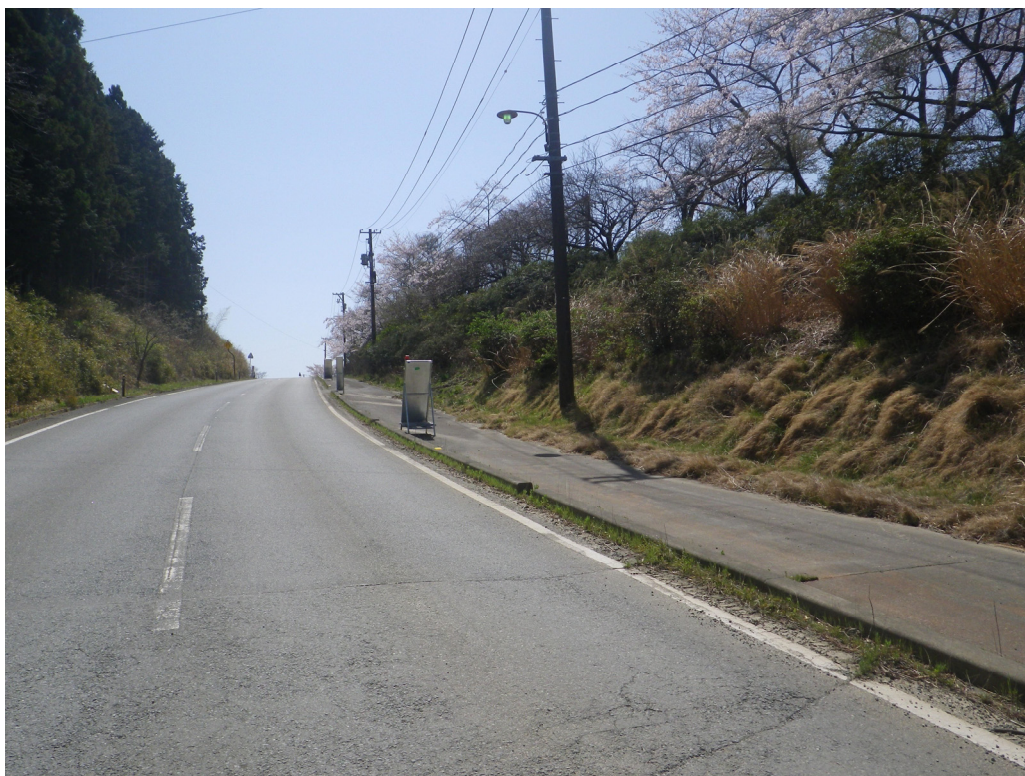
写真 9：現在の斜面状況(新たな崩壊は確認されない)。2021. 3. 31
