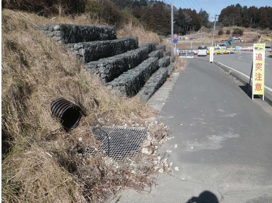
写真4：新たな土砂流出は確認されない。
