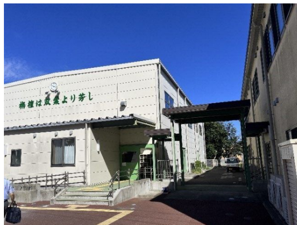
写真：仮設校舎（いわき市錦町）
