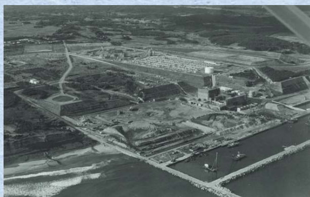
建設中の福島第一原子力発電所
