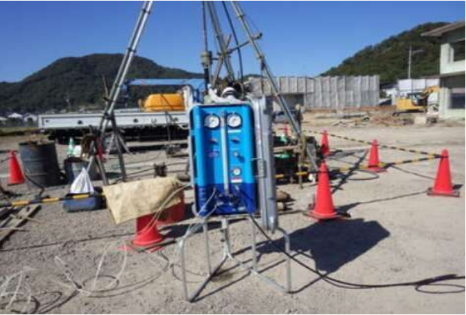
・孔内水平載荷試験作業
