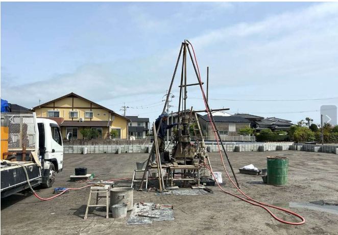
・地盤調査及びサンプリング作業
