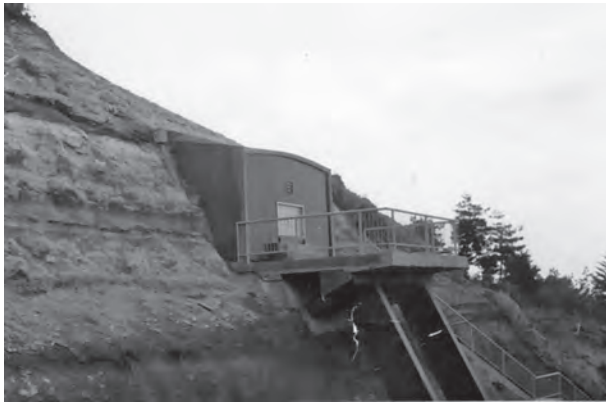
第3-33図 保存施設建設（1970年）
