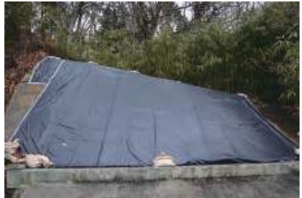
第3-56図 防水シート敷設
