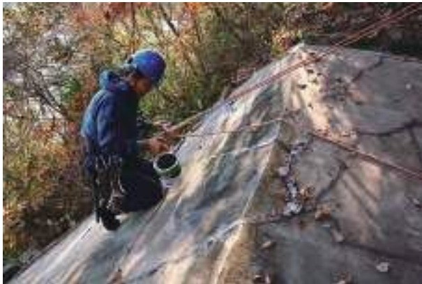
第3-55図 コンクリート壁のコーキング
