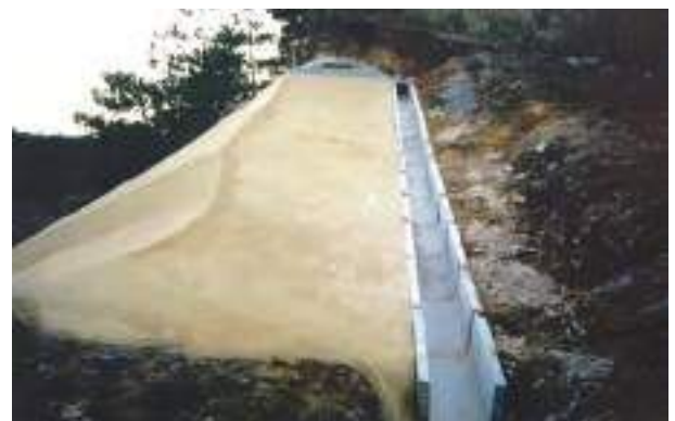
第3-36図 斜面被覆整備（1986年）
