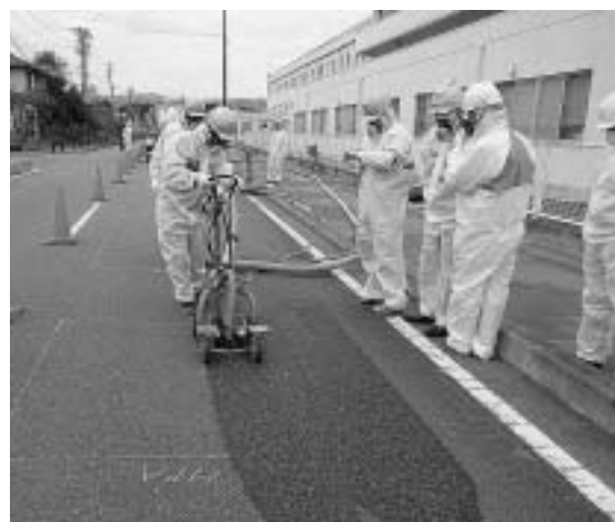
▲双葉厚生病院脇町道の高圧洗浄試験施工
