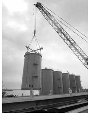
汚染水貯蔵タンク搬入の様子 ※東京電力HPより
