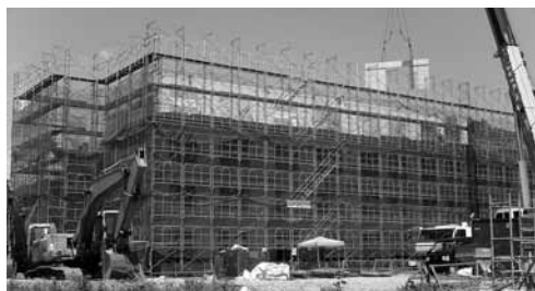
郡山市喜久田に建設中の復興公営住宅
