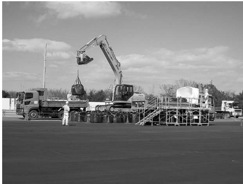
中間貯蔵施設の保管場(ストックヤード)のようす
