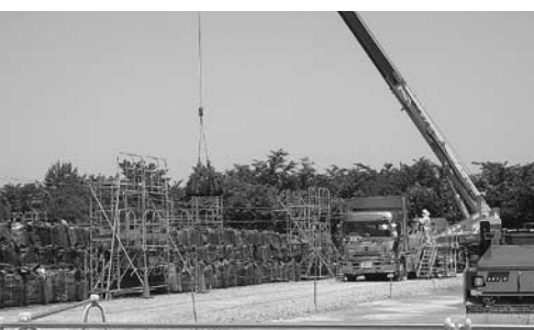
中間貯蔵に係る保管場のようす
