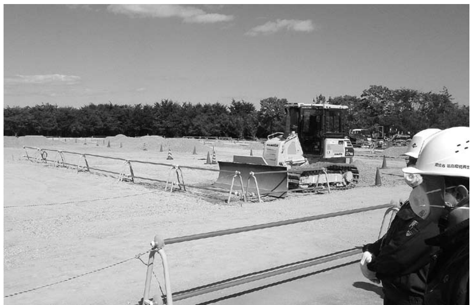
整備が進められている中間貯蔵施設保管場
