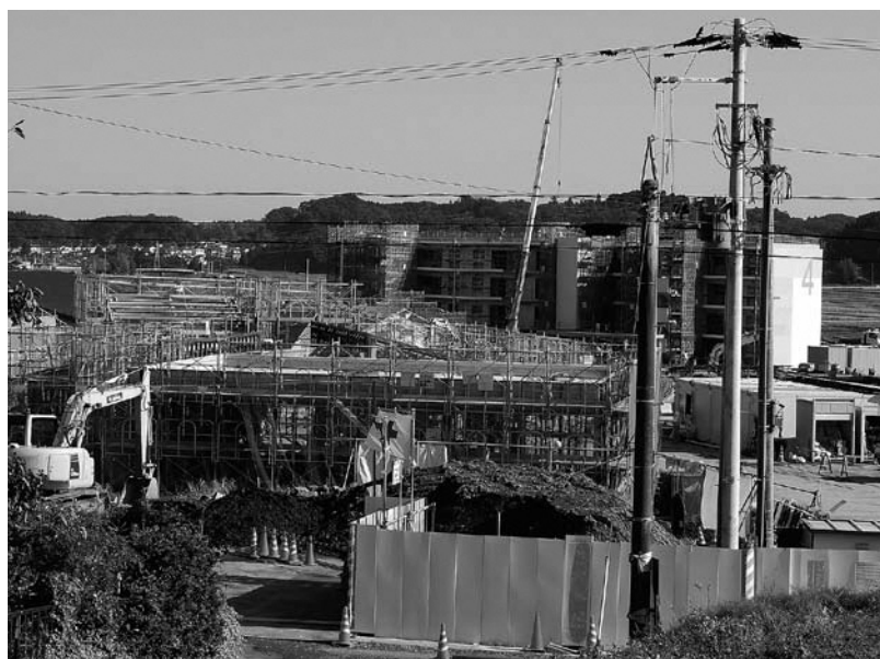
整備が進む勿来酒井復興公営住宅
