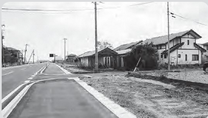
半壊の判定を受けた谷沢町住宅
