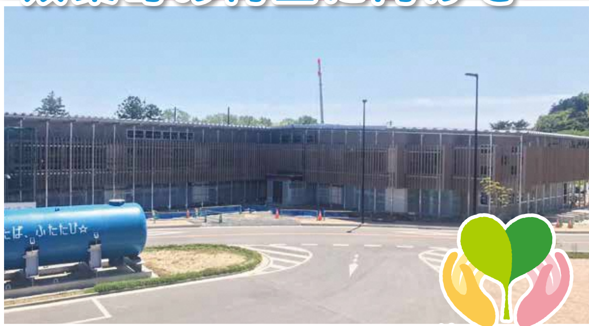
【建設中の役場仮設庁舎 5月10日撮影】
