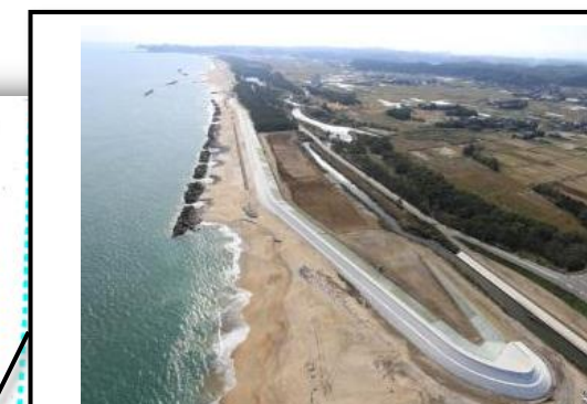
夏井海岸の海岸堤防（福島県いわき市） （復興庁 HP より）
