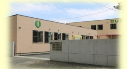
町立学校の仮設校舎
