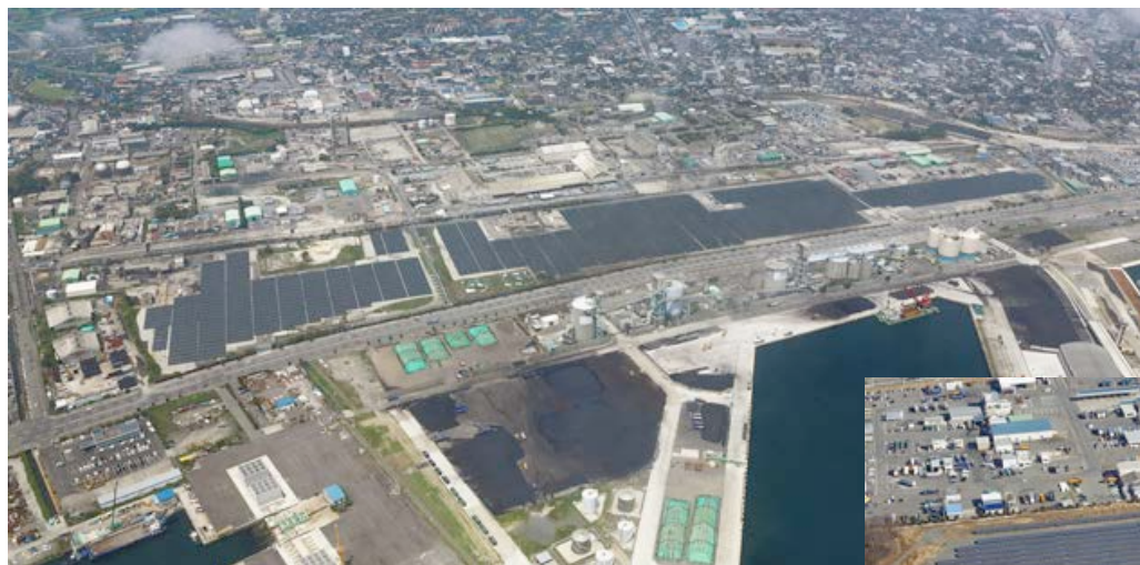
小名浜ソーラー発電所（12.2MW）
