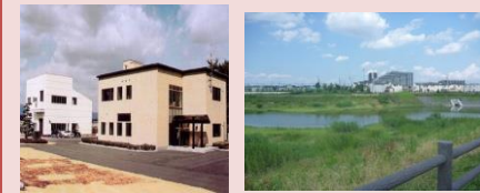
(参考: 左: 污水处理施設、右: 調整池)
