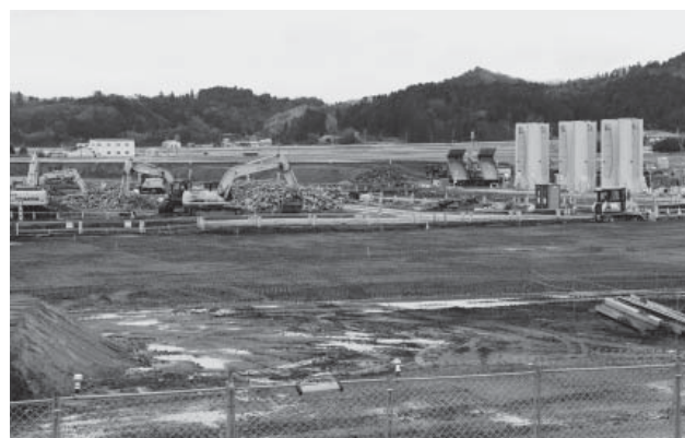
勿来酒井地区復興公営住宅基盤整備工事の様子
