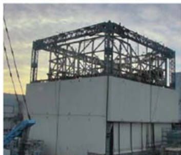
（1号機建屋カバー壁パネル取外状況）
