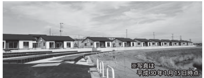
木造住宅の整備状況(敷地南側から)
