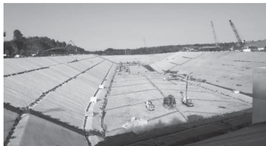
造成完了、遮水工施工中
