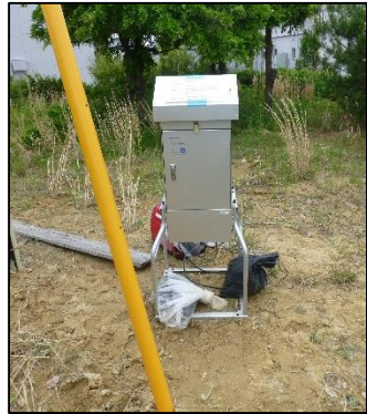
F-3 未舗装面
